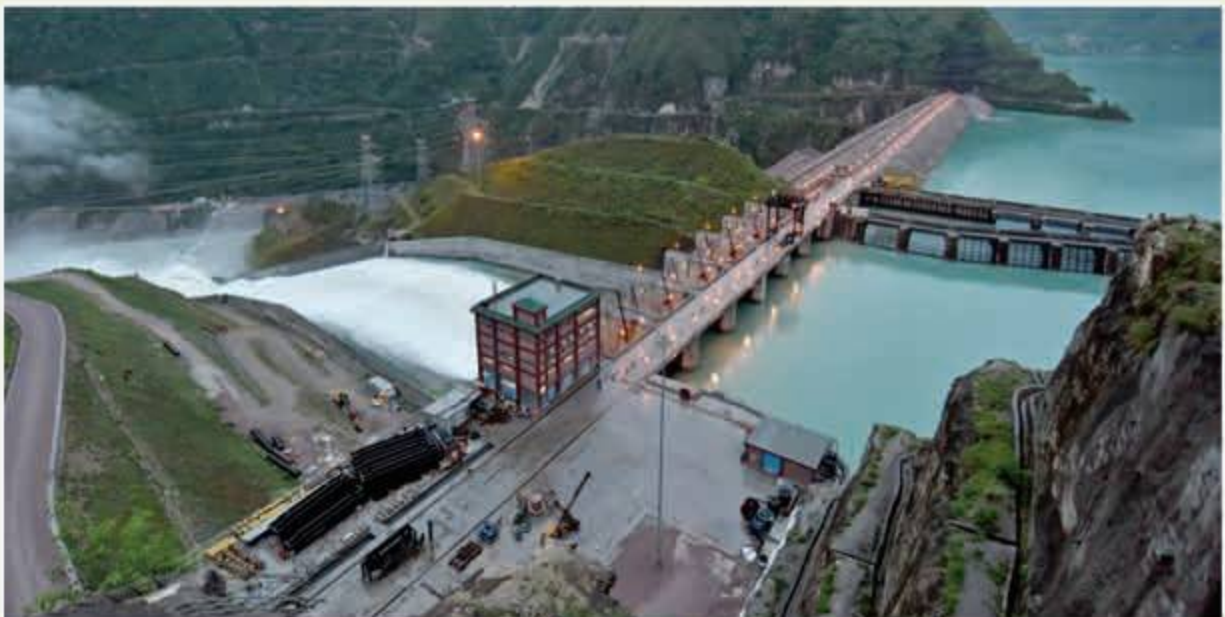
800 MW Koldam Hydro Project
